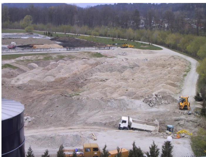
Slika 2: Zasipanje poglobljenega dela terena (Vir: naročnik elaborata)
